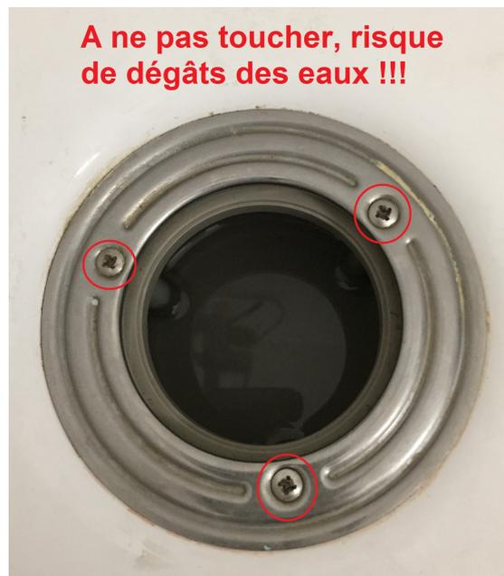
Enlever les vis du siphon donne accès à la dalle en dessous, qui ne doit pas être en contact avec de l'eau au risque de créer des fuite d'eau dans les murs !!! **Ne surtout pas enlever ces vis.**
